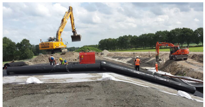
Aanleg N381 Drachten - Nanningaweg, AEC bodemas-afdichting met HDPE-folie.
