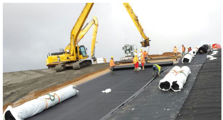
Aanleg combinatie-afdichting stortplaats AVRI Geldermalsen.
