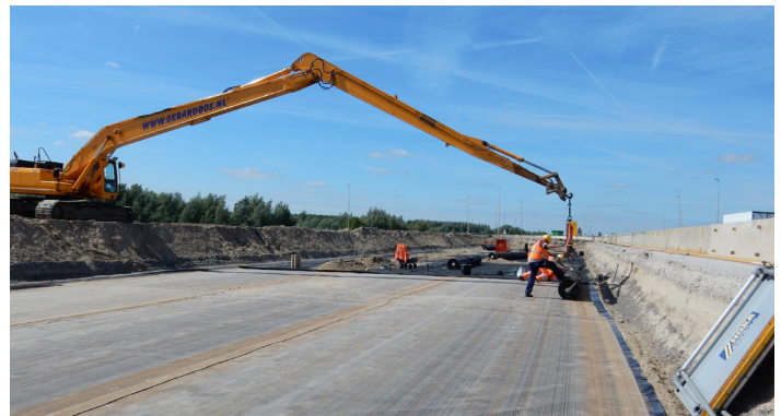
Renovatie A27 Flevoland, combinatie-afdichting HDPE-folie en bentonietmat.
